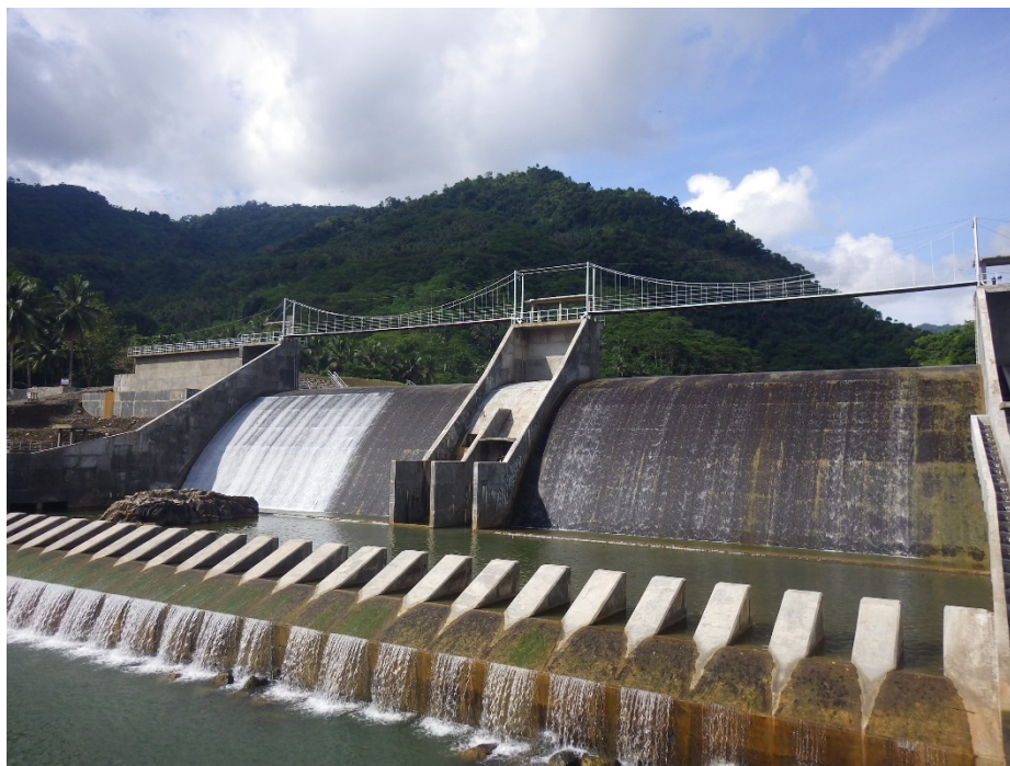
設置予定地 (稼働中の取水堰)
