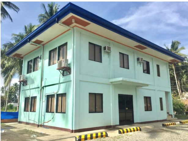
工業団地開発管理事務所
