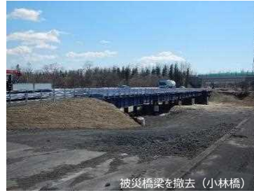
被災橋梁を撤去（小林橋）
