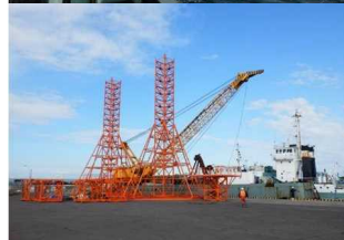
海上ボーリング調査
