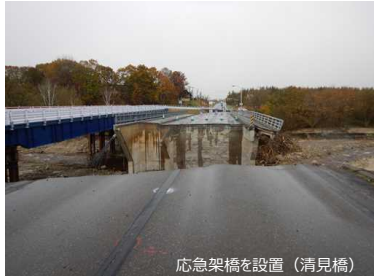
応急架橋を設置（清見橋）
