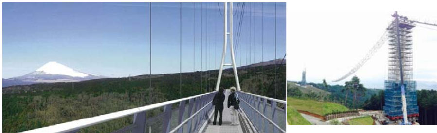
完成イメージと現在の架設状況
