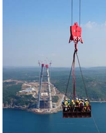
第3ボスボラス橋主塔
