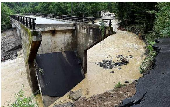
橋台背面の崩落
