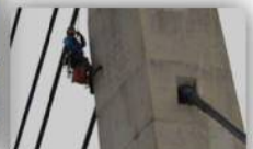
直接目視による点検の様子
