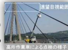
高所作業車による点検の様子
