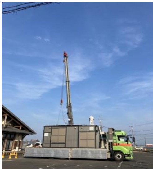
写真1 クレーンによるユニットの搬入（2026年8月3日）
