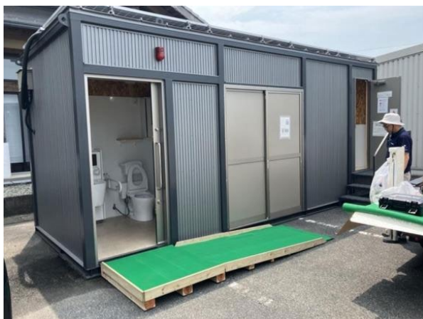
写真2 出入口にスロープを設け、段差を解消
