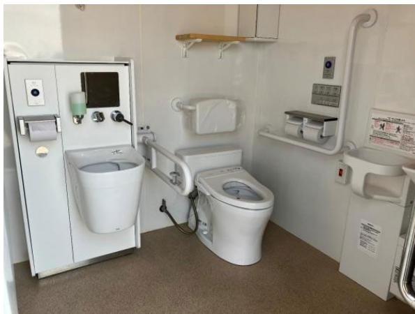
写真3 温水洗浄便座・手すり・ベビーチェア等を備えた内部
