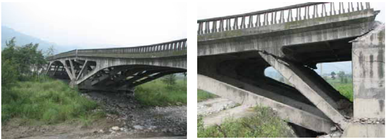
図 4-1 4 連のうち 2 連が崩壊し残った 2 連にも大きな損傷が生じた小魚洞大橋
