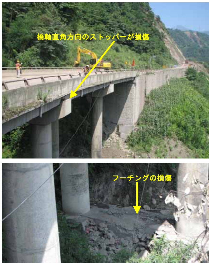
図 7-1 既設の桁橋（長大調査橋梁 No.1）
