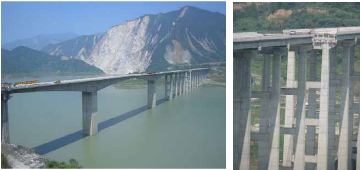
図 2-1 3 径間連続 PC ラーメン橋と PCT 桁の連結構造からなる廟紫坪大橋
