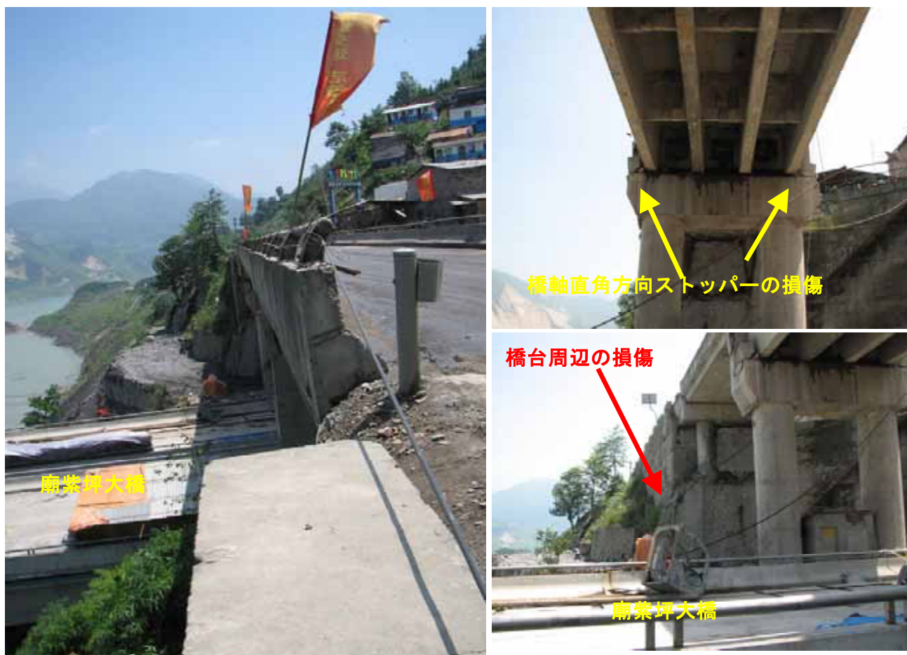
図 7-2 既設の桁橋（廟紫坪大橋の上を通る橋，長大調査橋梁 No.3）
