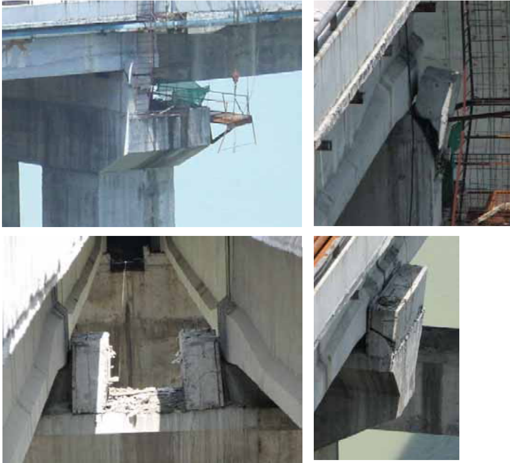
図 2-4 橋軸直角方向のストッパーの損傷状況
