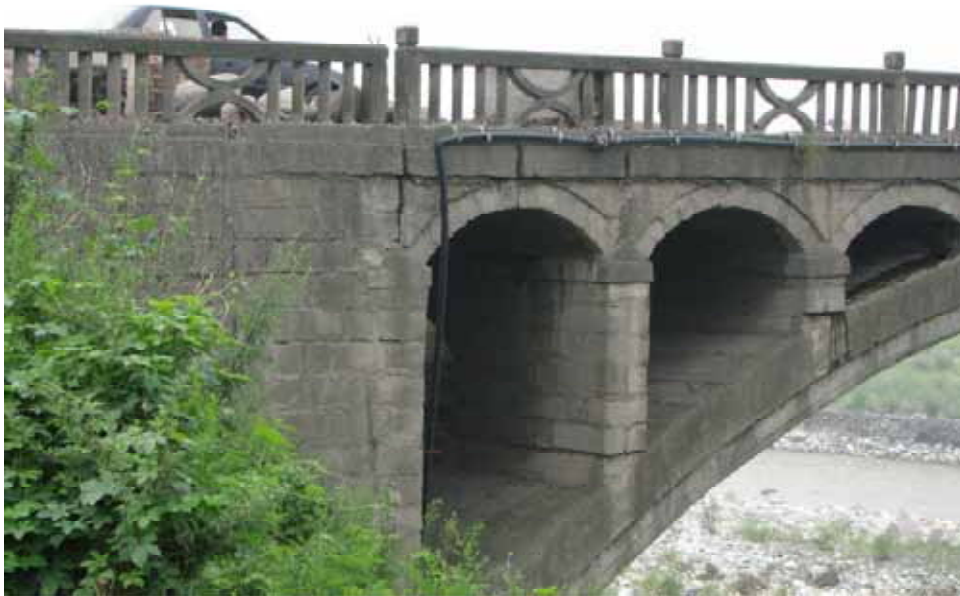
図 6-2 RC 製アーチ橋：関口大橋
