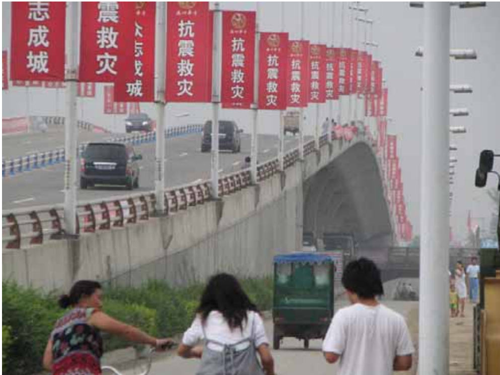
図 5-1 車線が規制されていたが交通量が多かった景観立交橋
