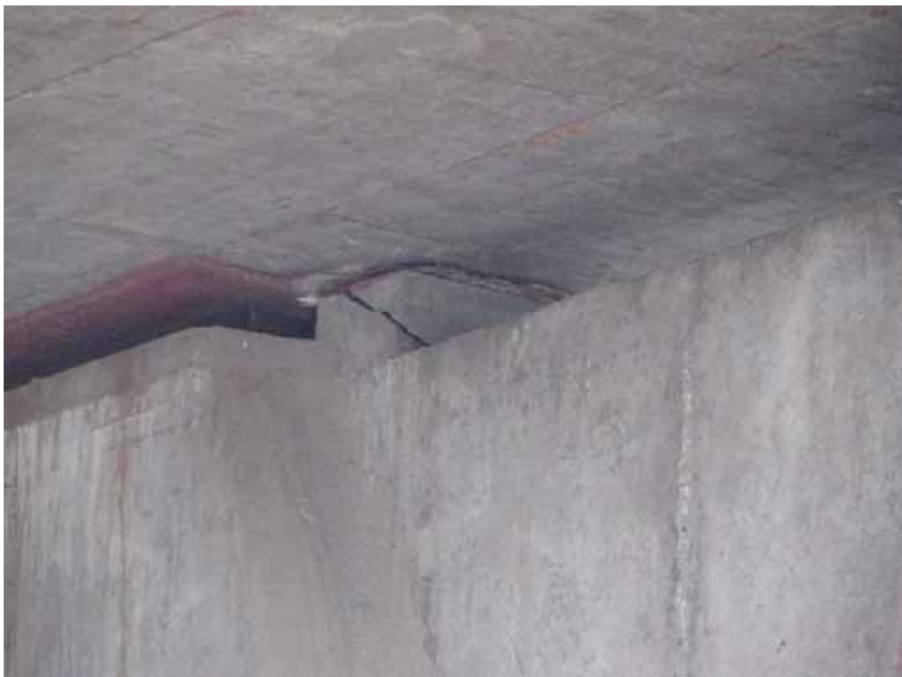
図 5-2 景観立交橋の橋軸直角方向ストッパーの損傷
