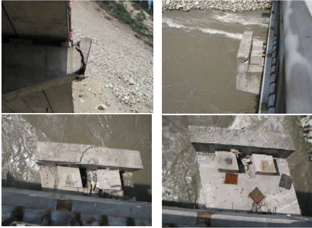
図 2-6 損傷した橋軸直角方向のストッパーと桁の変位
