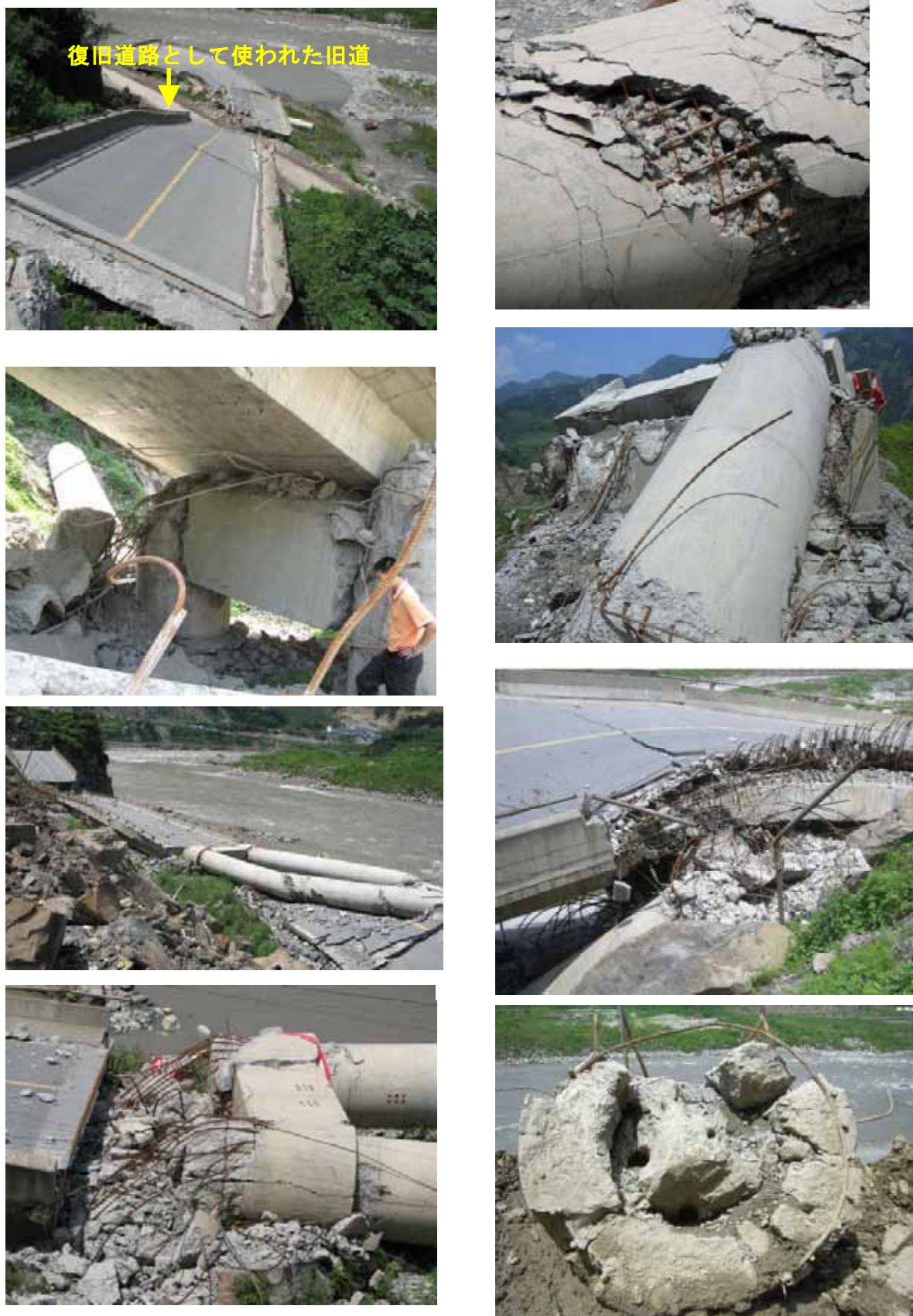
図 3-1 桁が落下し復旧道路を確保するために残存部分を爆破解体した百花大橋
