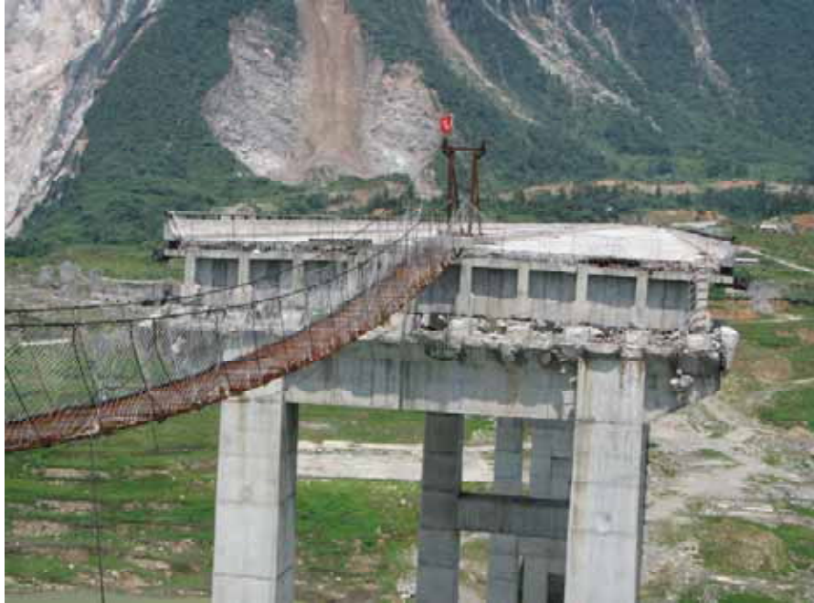
図 2-2 桁が落下した PC の T 桁区間
