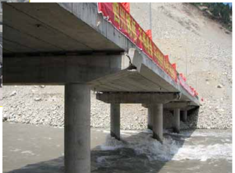
図 2-5 損傷した工事中の橋梁 (映秀岷江大橋)
