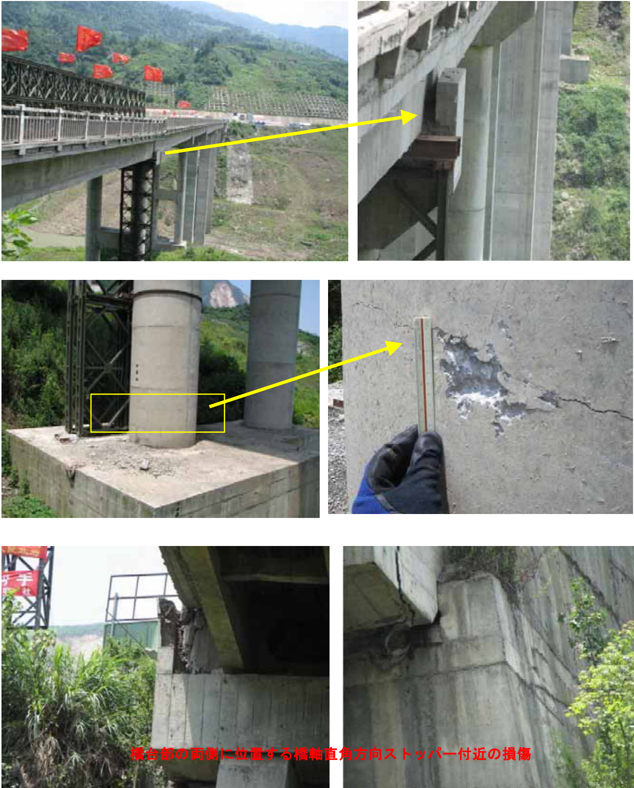
図 7-3 既設の桁橋：寿江大橋（建設されてから長い時間が経過していないようである。）
