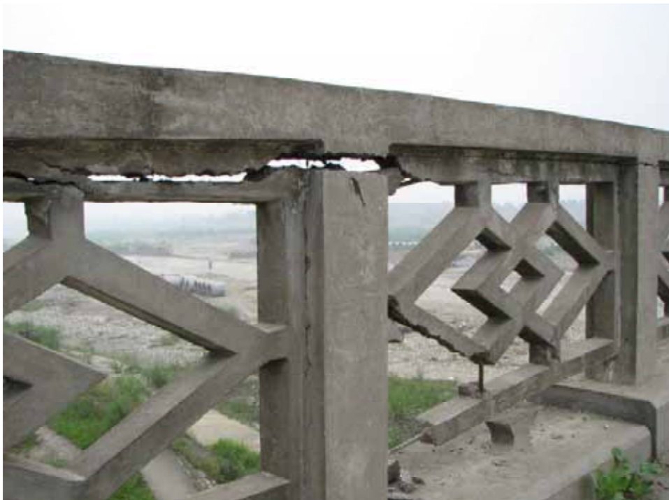
図 6-1 RC 製アーチ橋：川西大橋
