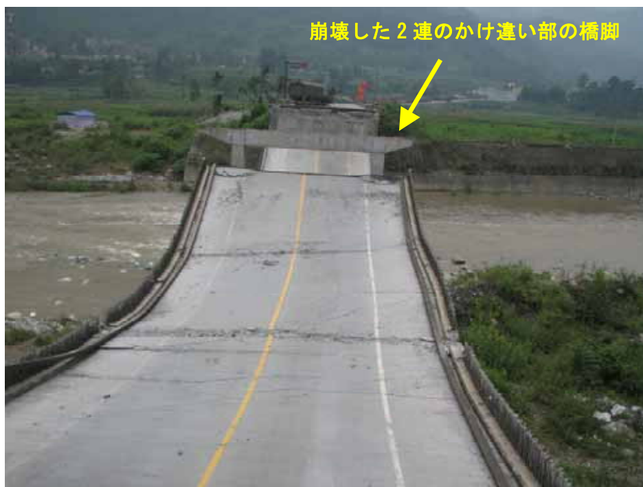
図 4-2 河川内にある崩壊した 2 連のかけ違い部の橋脚
