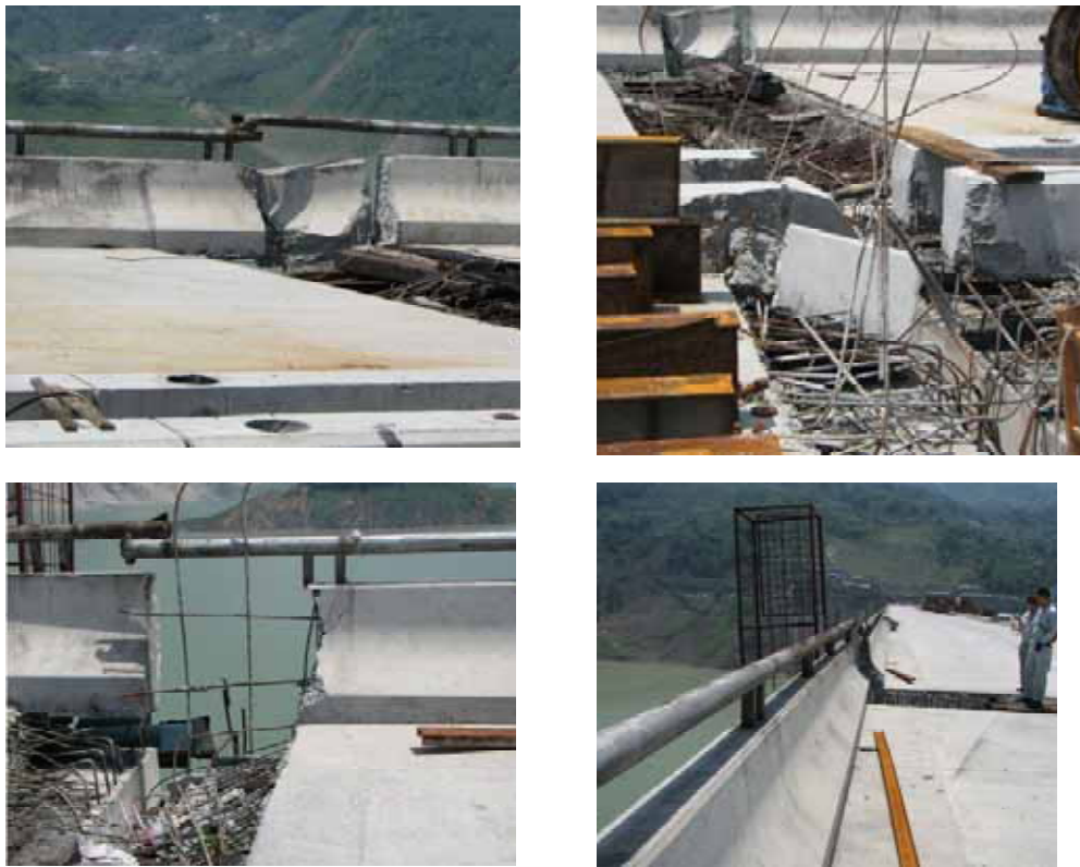
図 2-3 3 径間連続 PC ラーメン橋と PC の T 桁区間のかけ違い部の伸縮部の損傷
