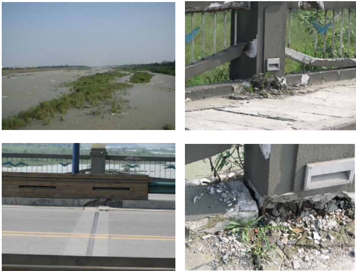
図 7-5 既設の桁橋（都江堰付近の橋梁，長大調査橋梁 No.9）
