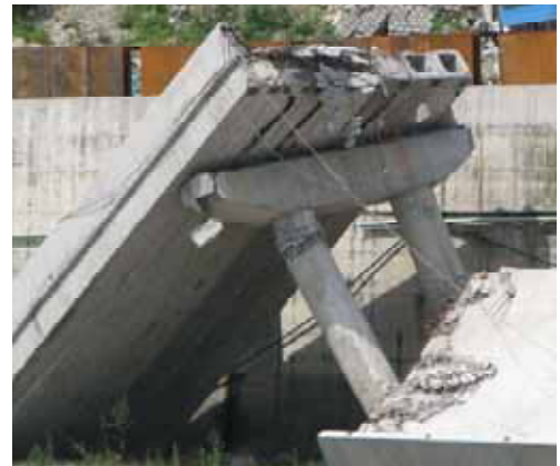
図 2-6 損傷した橋軸直角方向のストッパーと桁の変位
