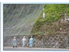
写真③のり面点検
