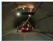
写真②トンネル点検
