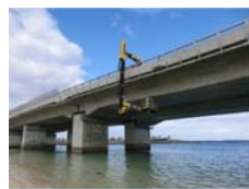
写真①橋梁点検
