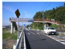
写真④横断歩道橋点検
